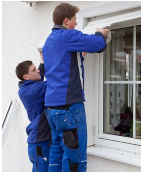
Einsatz vor Ort: Die bestellte Rollladenanlage wird beim Kunden montiert.
